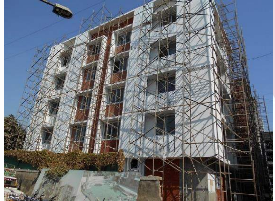
Block A Actual Construction
